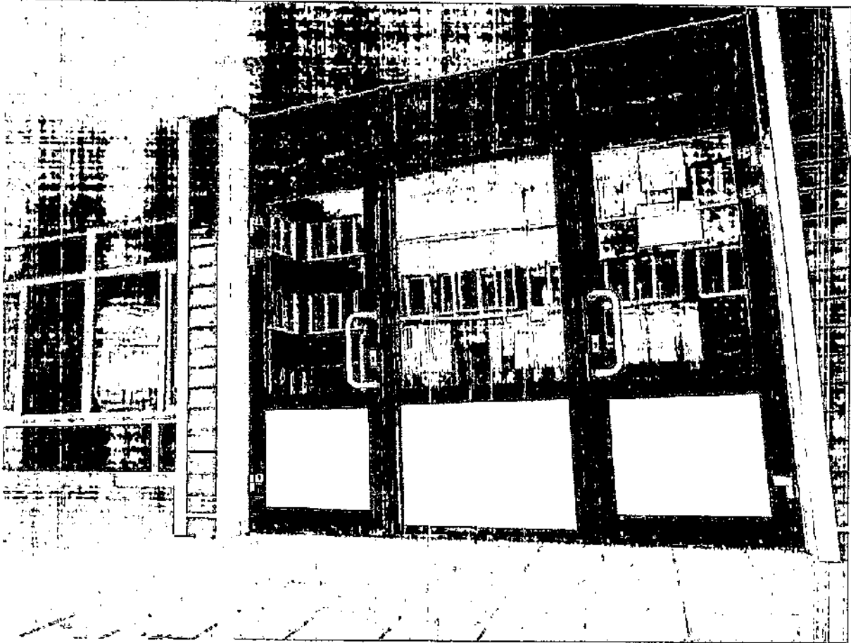
Фото 15. Входная площадка перед дверью
